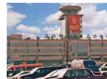
Аэровокзальный комплекс «Домодедово»
