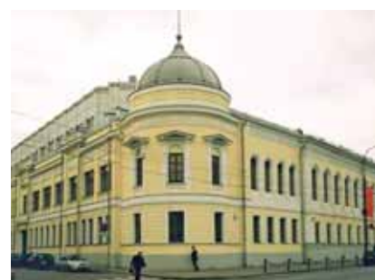
Бизнес-центр, ул. Воздвиженка, вл. 9
